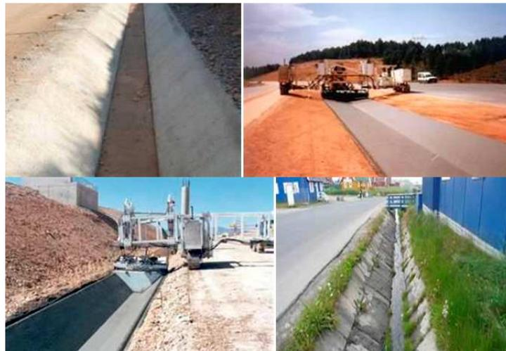
Imagen 3-6. Diferentes tipologías de cunetas y de ejecución de las mismas
