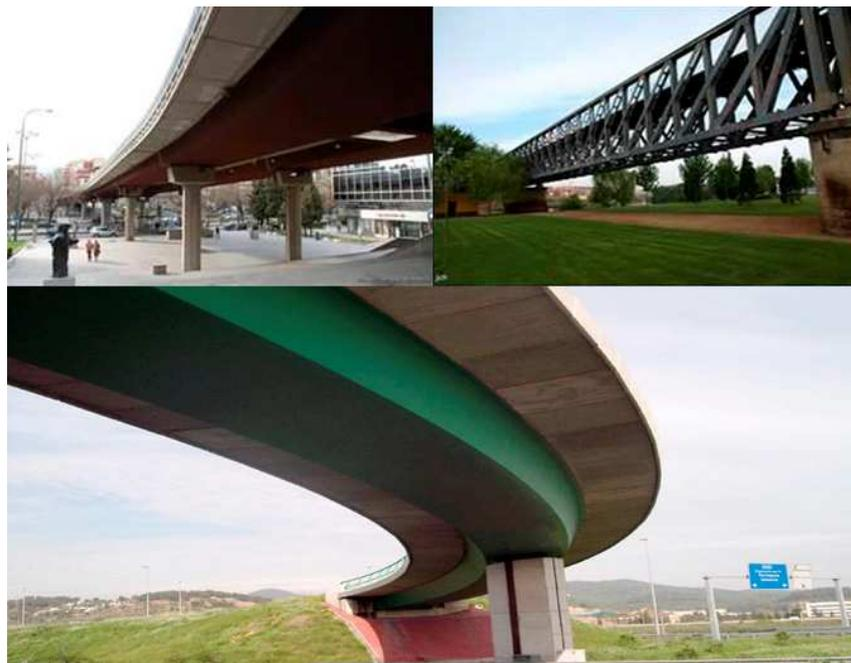
**Imagen 3-12.** Soluciones de estructuras mixtas con vigas metálicas, celosía y cajón.
