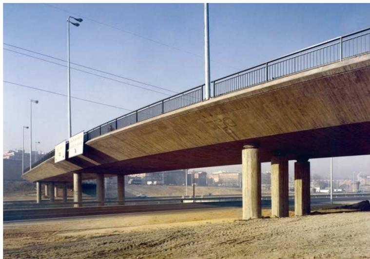
**Imagen 3-14.** Puente postensado in situ de canto constante.
