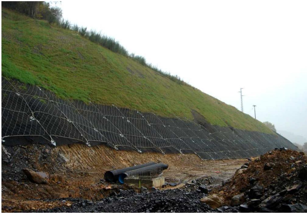
Imagen 3-27. Detalle de corrección geotécnica en talud.
