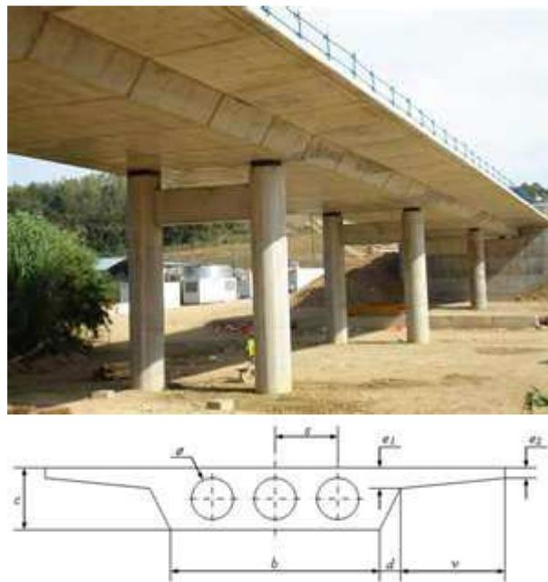
Imagen 3-10. Ejemplo de puente de losa ejecuta con aligeramientos circulares.
