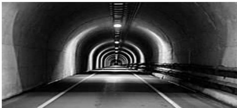
**Imagen 3-22.** Diferentes imágenes de túneles con geometría de herradura.
