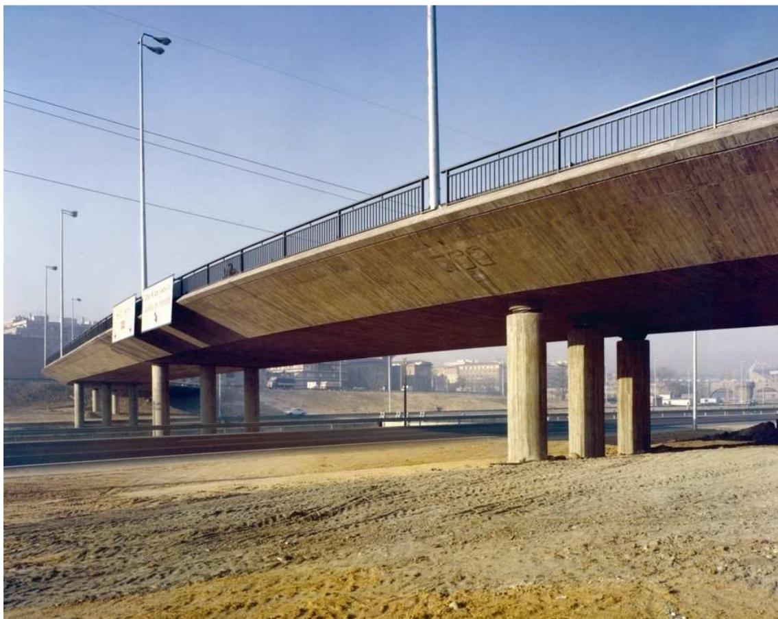
Image 3-14. Pont avec poutres d'épaisseur constante précontraintes in situ.
