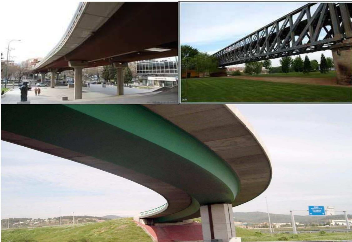
Image 3-12. Solutions de structures mixtes avec poutres métalliques, treillis et caisson.
