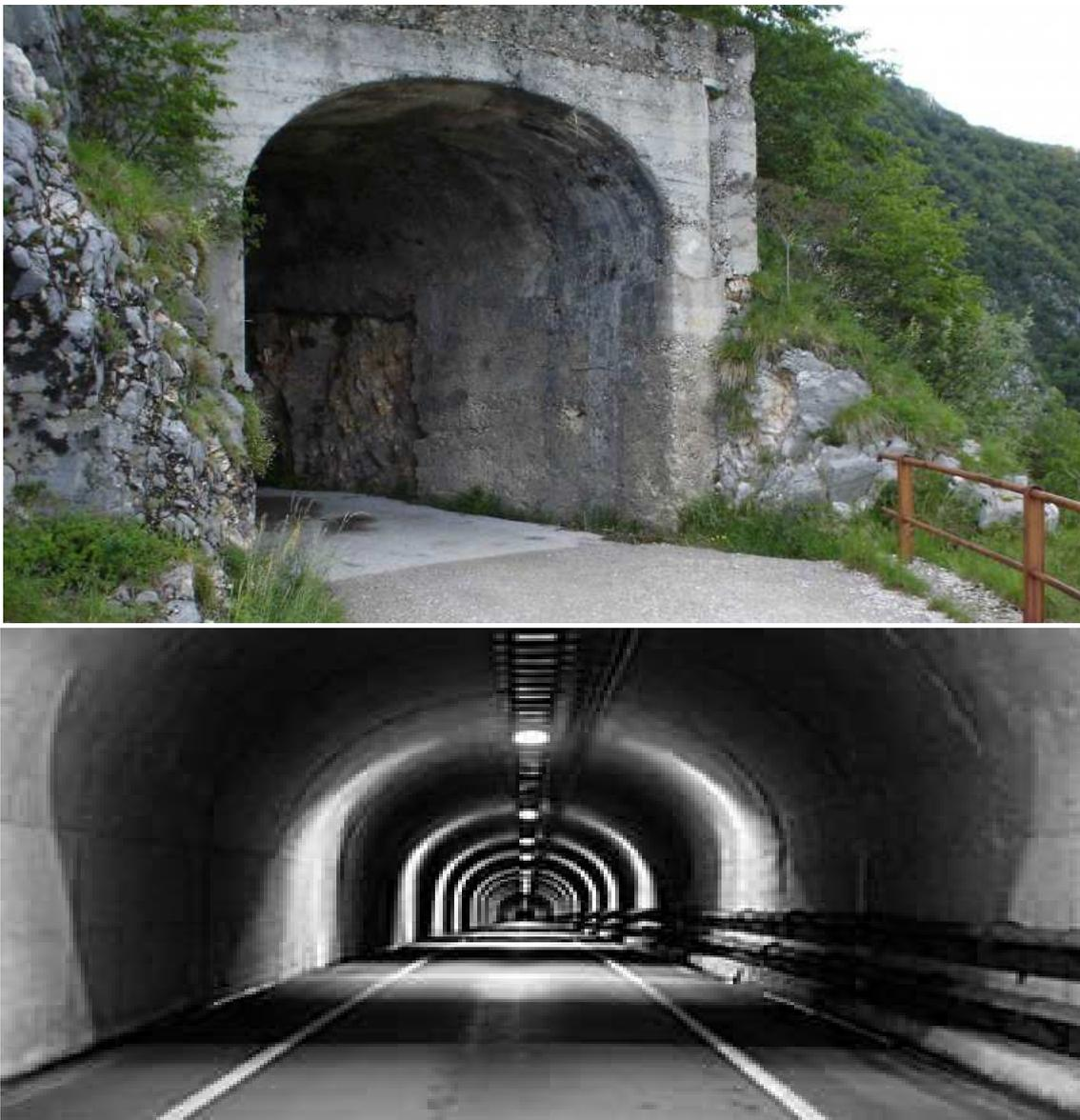
Image 3-22. Différentes images de tunnels avec géométrie en fer à cheval.
