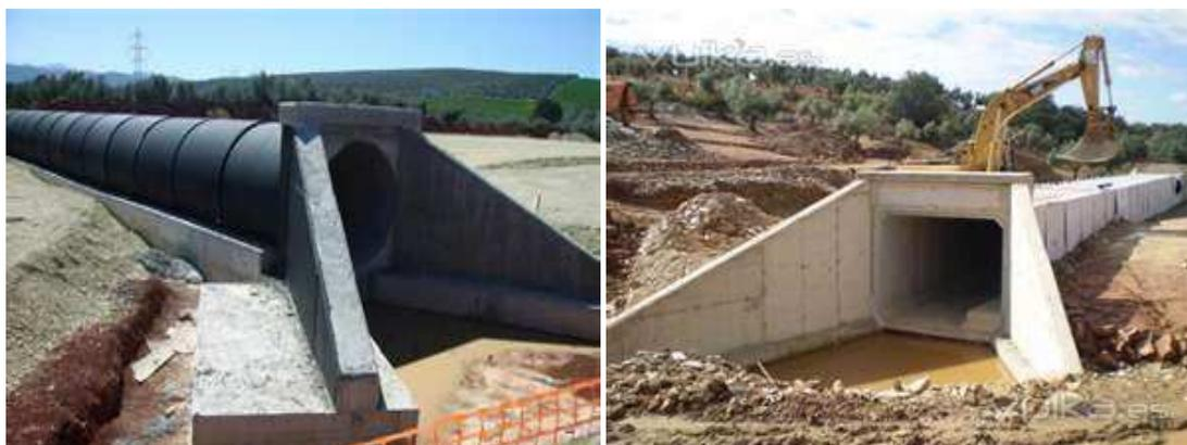
Image 3-23. Différentes images de travaux de drainage transversal.
