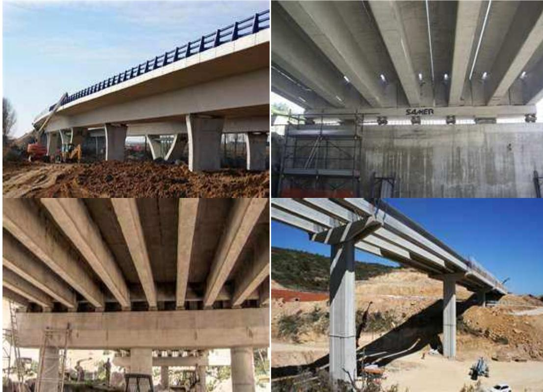
Image 3-9. Différentes typologies de ponts préfabriqués avec poutres de pétrin o sur I
