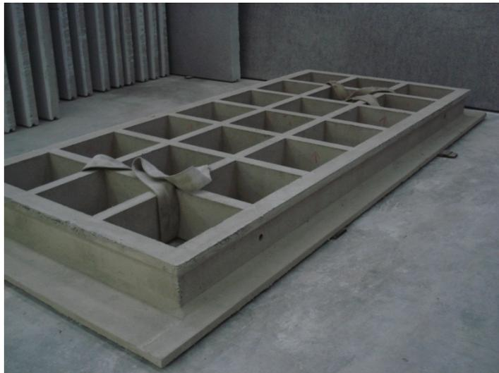
Imagen 43. Detalle de forjado discontinuo de 35 cm de canto.
