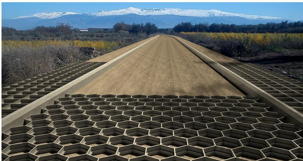
Imagen 14. Empleo de dos formatos de pavimento in situ.
