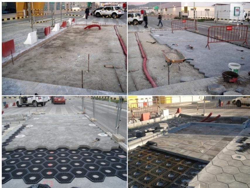
Imagen 11. Diferentes etapas ejecución pavimento prefabricado desmontable.
