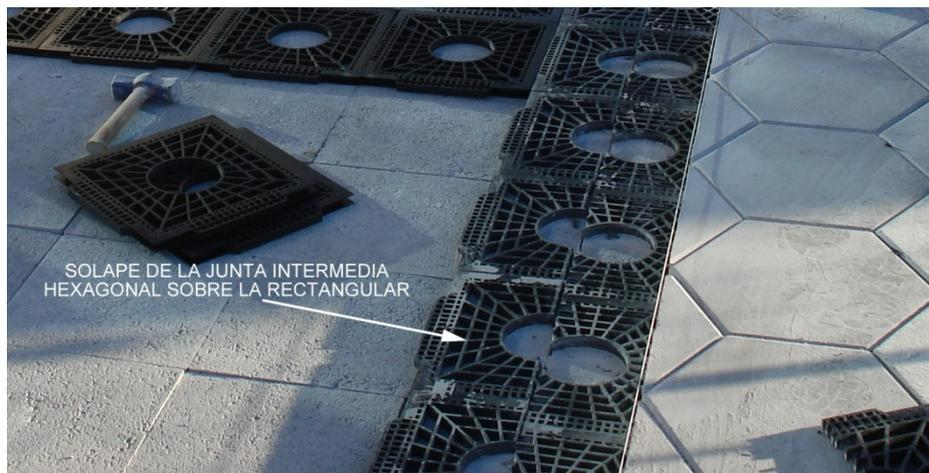
Imagen 13. Detalle de solape de la junta intermedia.
