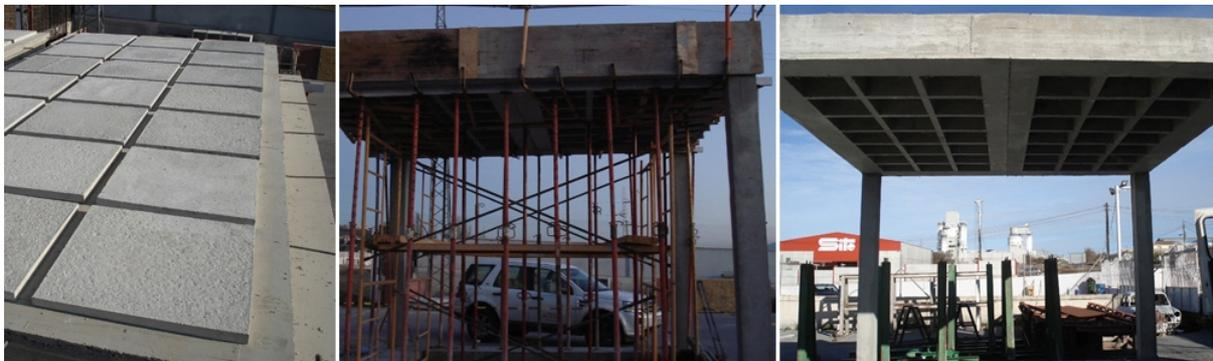
Imagen 53. Colocación de prelosas, encofrado, relleno de hormigón y desencofrado final.
