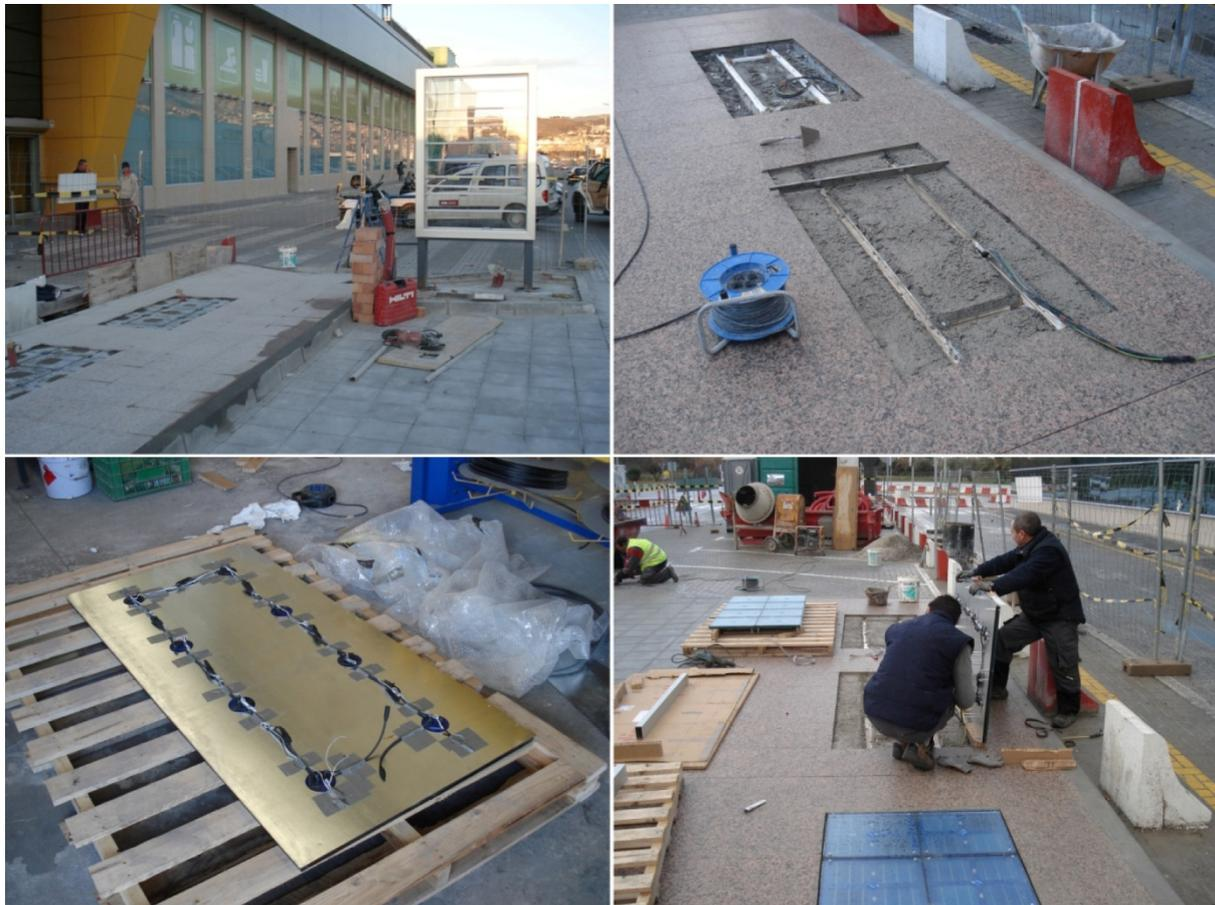
Imagen 31. Instalación de baldosas solares.
