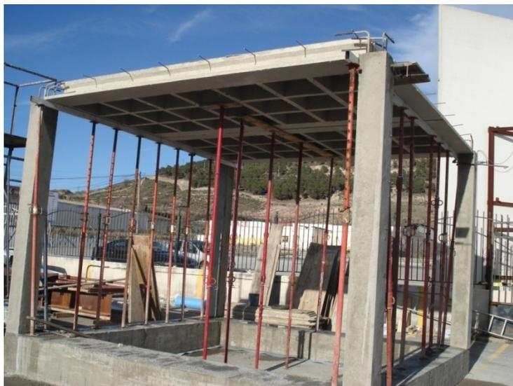
Imagen 52. Colocación de paños prefabricados.
