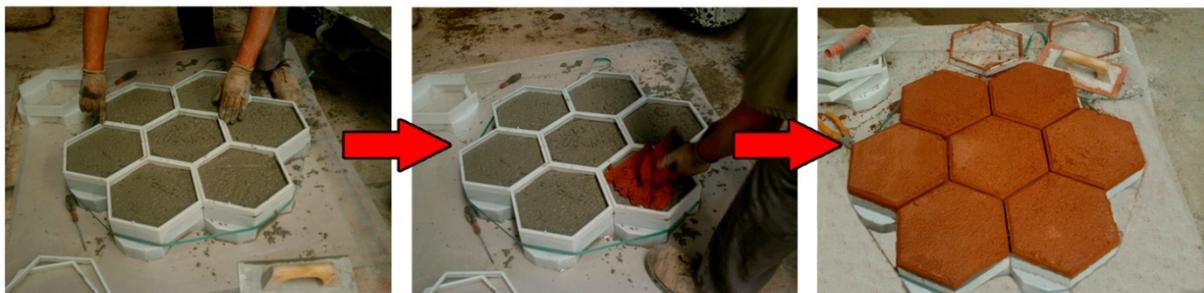
Imagen 3. Imágenes de pavimento desmontable in situ.
