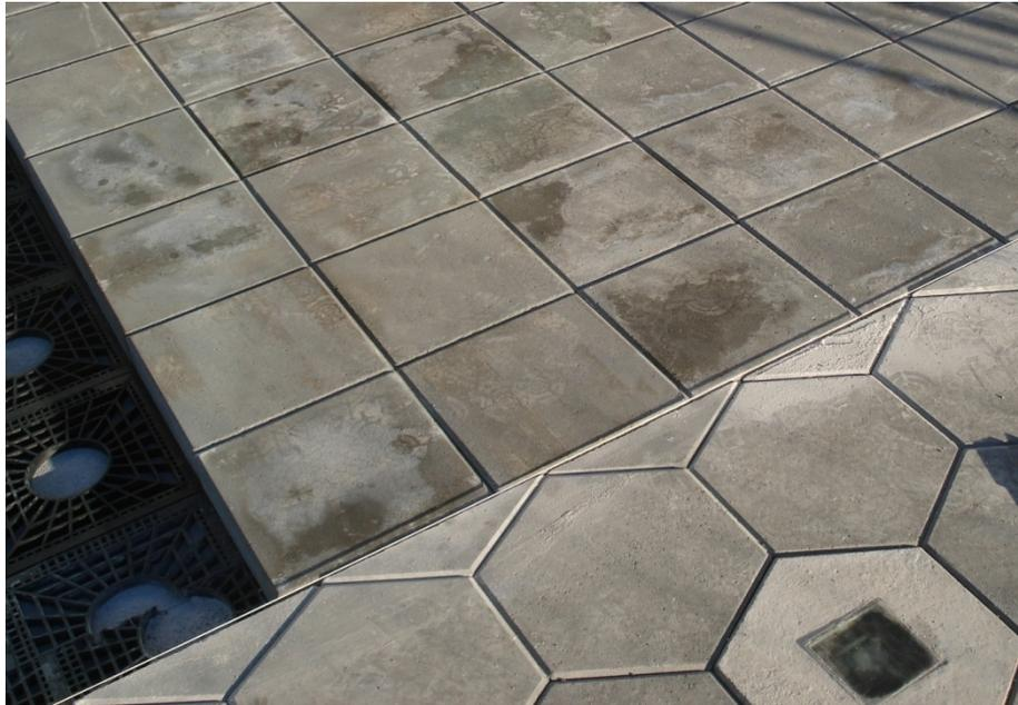
Imagen 1. Pavimento desmontable prefabricado con dos formatos
