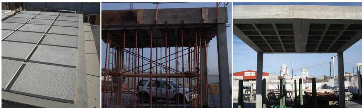
**Image 53.** Placement de prédalles, coffrage, remplissage de béton et décoffrage final
