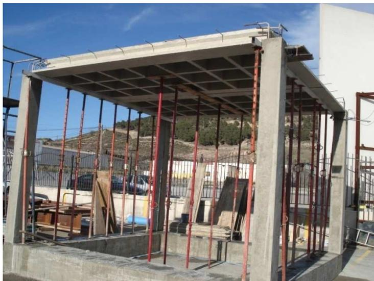
**Image 52.** Emplacement de panneaux préfabriqués.
