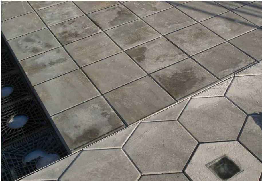
**Image 1.** Pavé démontable préfabriqué avec deux formats.
