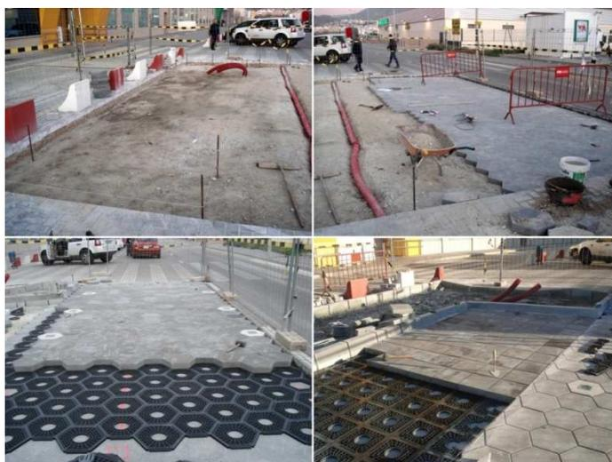
Image 11. Différentes étapes d'exécution du pavé préfabriqué démontable.
